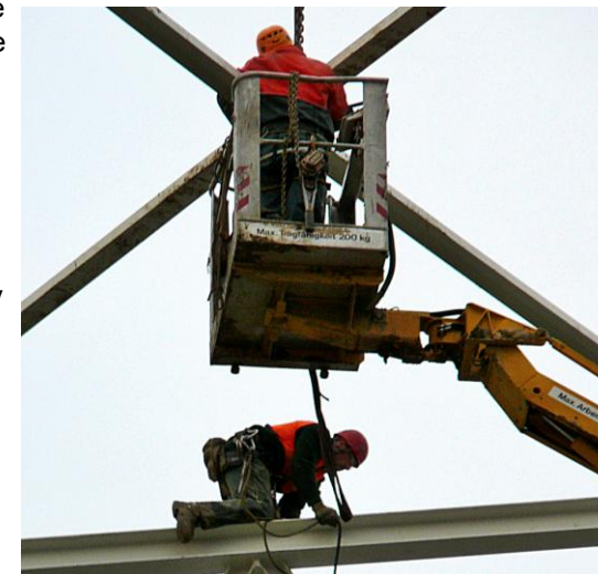
2: Alternative zu Bild 1: Zugang mittels Hubarbeitsbühne
